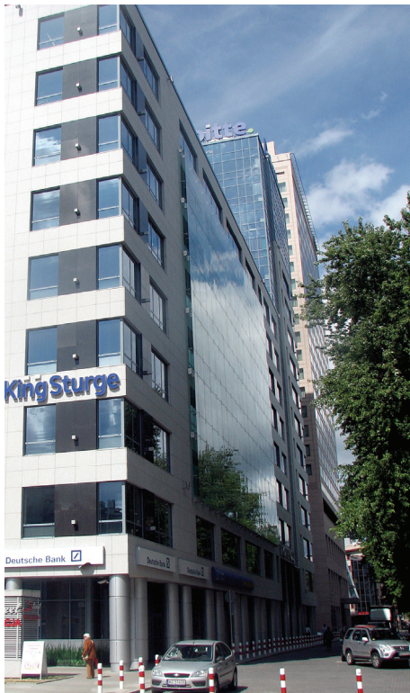
Fot. 14. Elewacje budynku Atrium City, Warszawa. Zastosowanie tzw. „podwójnej skóry” (zdjęcie autora)
