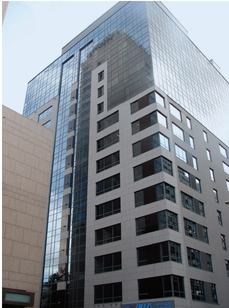
Fot. 13. Elewacje budynku Atrium City. Warszawa. Zastosowanie przeszkleń w formie otworów okiennych i kurtyny szklanej (zdjęcie autora)
