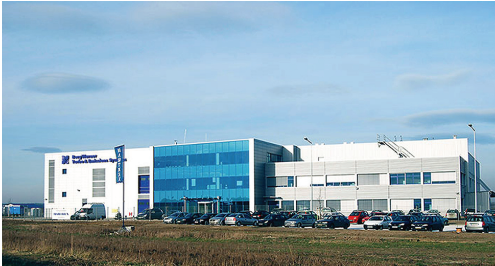
Fot. 4. Budynek koncernu Borg Warner w Rzeszowie (źródło: rzeszow4u.pl)
