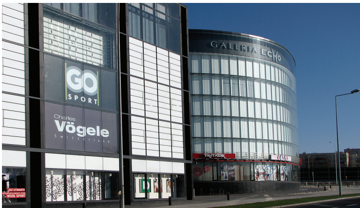
Fot. 25. Widok od strony ulicy
