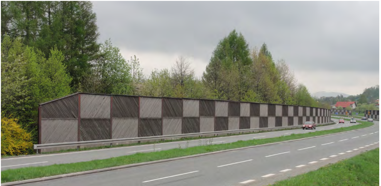
Fig. 2. Reflective noise barrier (authors' photography) Rys. 2. Odbijający ekran akustyczny (fotografia autorów)
