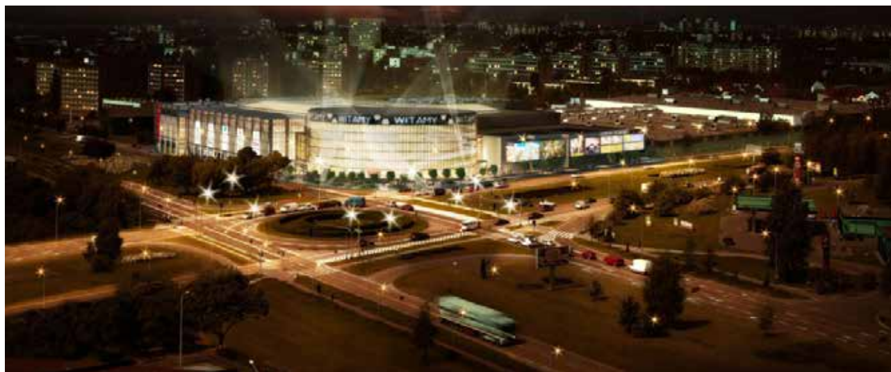
Photo 8. Galeria Echo Shopping and Entertainment Mall, the general view (source: Open Architekci) Foto 8. Centrum Handlowo-Rozrywkowe „Galeria Echo” – widok ogólny (źródło: Open Architekci)
