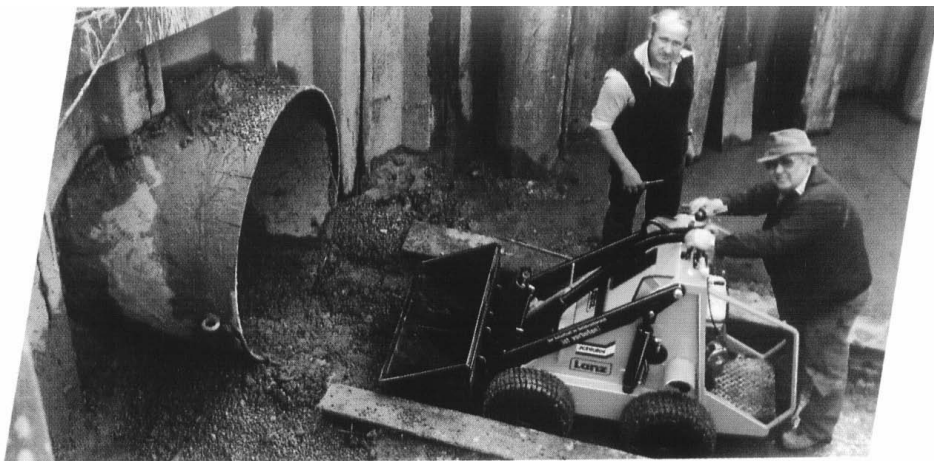
Rys. 2.19. Usuwanie urobku z wnętrza rury mini ładowarką, [73]
