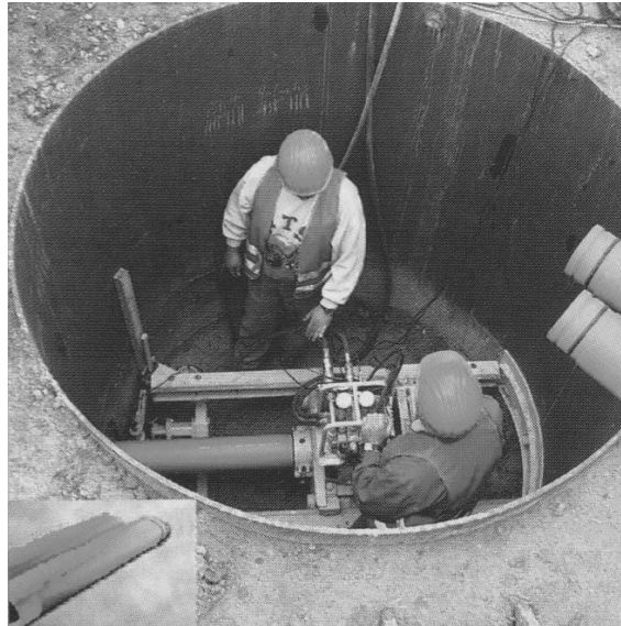
Rys. 3.39. Przecisk rur polipropylenowych, [67]
