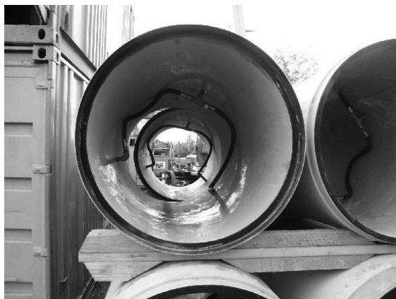
Rys. 2.99. Składowanie rur bentonitowych z widoczną instalacją do podawania płuczki bentonitowej, [2]
