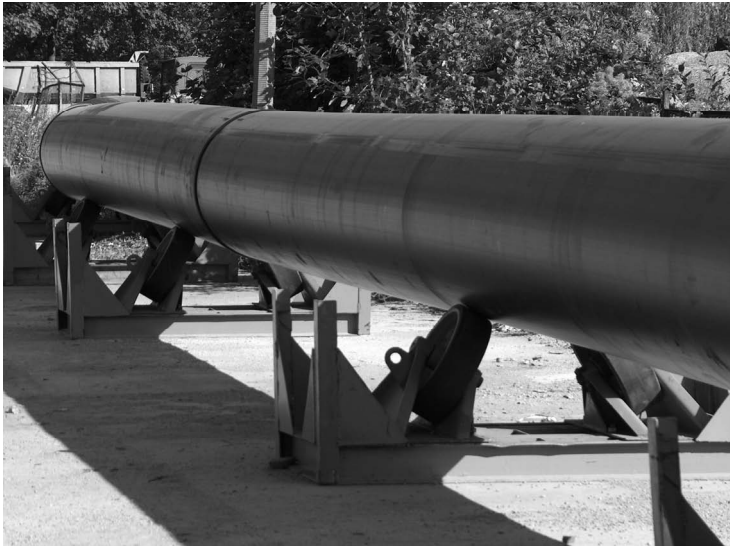
Rys. 2.34. Prowadnice rolkowe (zdjęcie własne dzięki uprzejmości firm B.D.C. Poland oraz JT – Zakład Budowy Gazociągów)
