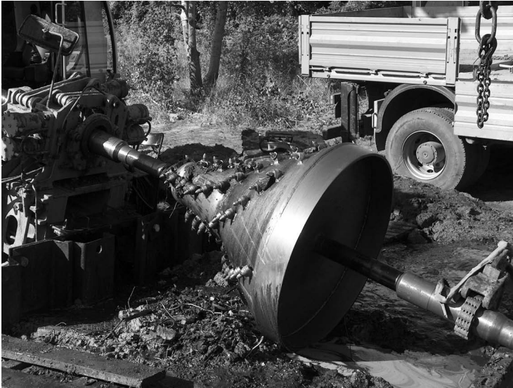
Rys. 2.33. Wyjście rozwiertaka po kolejnym marszu rozwiercającym (zdjęcie własne dzięki uprzejmości firm B.D.C. Poland oraz JT – Zakład Budowy Gazociągów)
