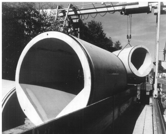
Rys. 3.26. Żelbetowe rury przeciskowe o przekroju specjalnym, [25]
