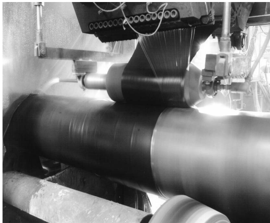
Rys. 3.11. Nakładanie wyprawy zewnętrznej na rurę stalową w zakładzie produkującym rury, [64]
