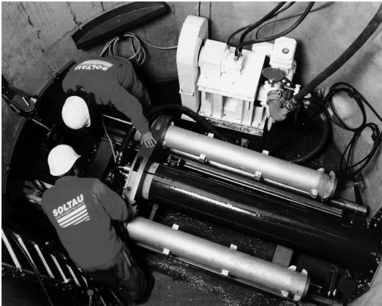
Rys. 2.94. Główna stacja przeciskowa z siłownikami ułożonymi po bokach rury przeciskowej, [68]
