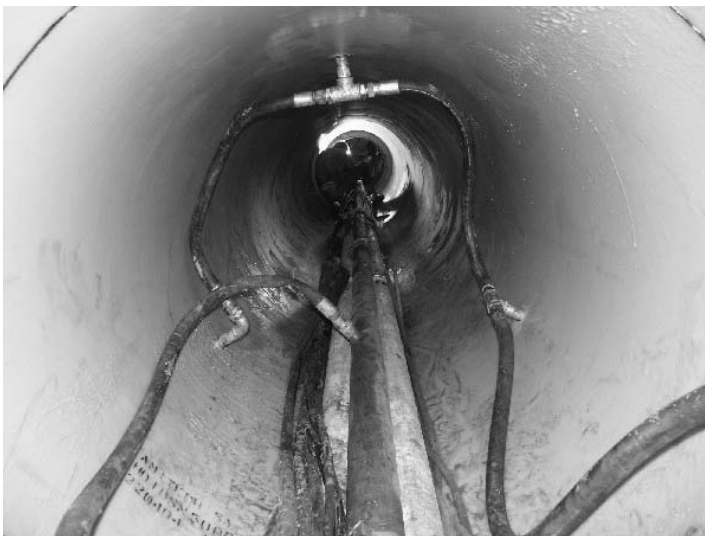
Rys. 2.97. Wnętrze wbudowywanego rurociągu z dyszami rozmieszczonymi na obwodzie rury oraz przewodami prowadzącymi płuczkę bentonitową do smarowania zewnętrznej powierzchni rur, [2]
