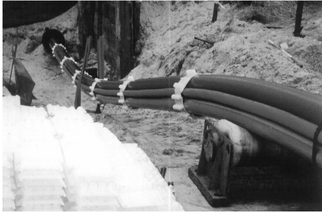
Rys. 3.3. Wciąganie przewodów w jednej wiązce: wodociągowych, kanalizacyjnych i innych zabezpieczonych powłokami antydyfuzyjnymi, [18]
