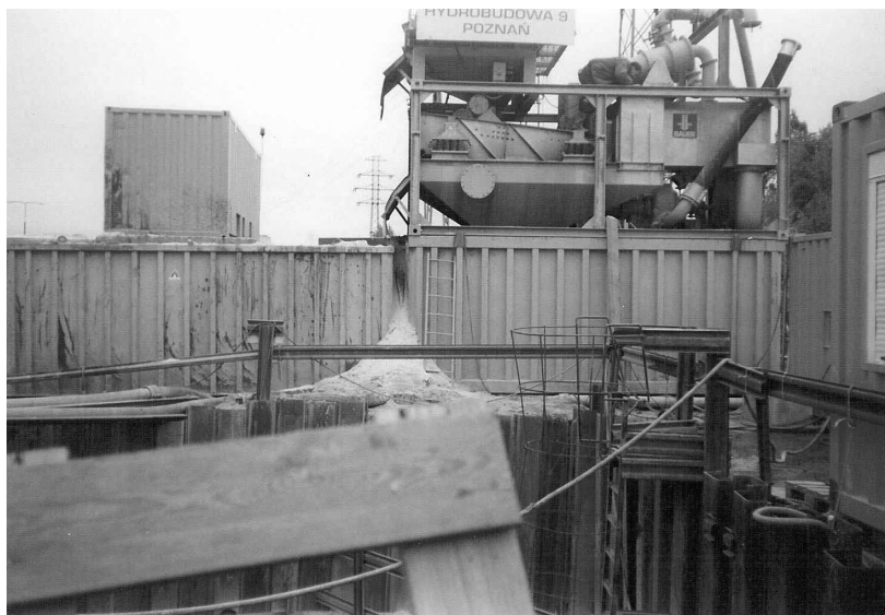
Rys. 2.96. System separacji płuczki (zdjęcie własne dzięki uprzejmości firmy HYDROBUDOWA – 9 Poznań)
