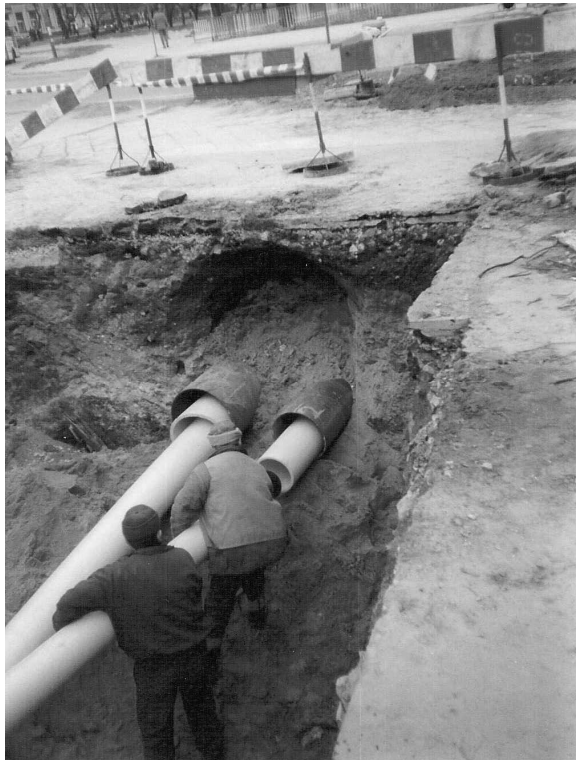
Rys. 2.53. Wciąganie rur przewodowych (zdjęcie własne dzięki uprzejmości firmy ZRUG Tarnów)
