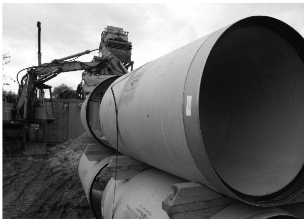
Rys. 3.34. Rury przeciskowe żywiczne wzmocniane włóknem szklanym, [2]
