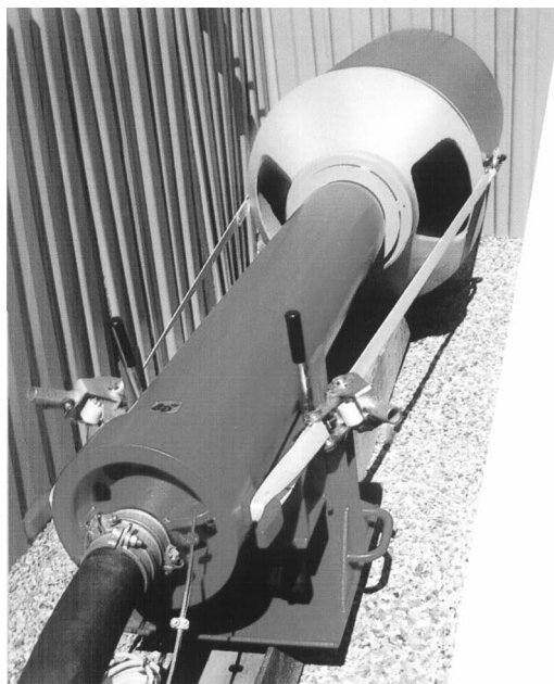
Rys. 2.18. Wbijanie rur stalowych. Na pierwszym planie przebijak pneumatyczny umieszczony w łożu, na drugim planie pierścienie pośrednie (stożki redukcyjne), adapter, wbijana rura stalowa, [73]
