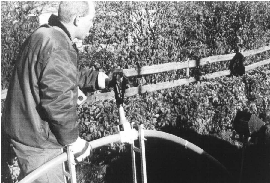
Rys. 2.15. Wąż zasilająco-sterujący umożliwiający sterowanie przeciskiem, [73]
