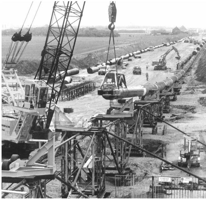
Rys. 2.35. Rurociąg przygotowany do wciągania, ułożony na specjalnej konstrukcji wsporczej, [1] Fig. 2.35. A pipeline ready to pull in, placed on a special supporting construction, [1]
