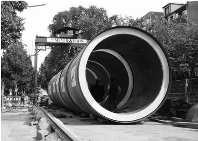
Rys. 3.21. Przeciskowe rury polimerobetonowe – POLYCRETE, [50]
