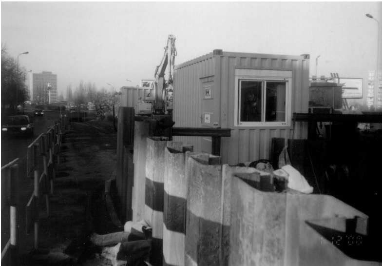
Rys. 4.14. Kontener sterowniczy umieszczony przy wykopie początkowym (zdjęcie własne dzięki uprzejmości firm HERRENKNECHT oraz HYDROBUDOWA – 9 Poznań)
