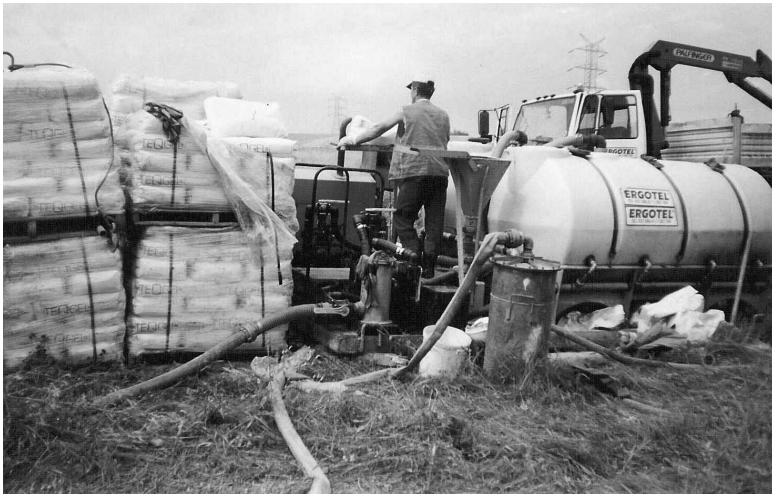
Rys. 2.43. Przygotowywanie płuczki bentonitowej (zdjęcie własne dzięki uprzejmości firmy ERGOTEL) Fig. 2.43. Preparation of drilling fluid (photo courtesy of ERGOTEL firm)
