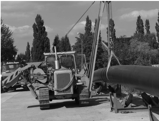
Rys. 2.36. Konstrukcja rurociągu podwieszona na samojezdnych dźwigach w czasie jego wciągania (zdjęcie własne dzięki uprzejmości firm B.D.C. Poland oraz JT – Zakład Budowy Gazociągów) Fig. 2.36. A pipeline underslung to cranes during its pulling in (photo courtesy of B.D.C. Poland firm and JT – Zakład Budowy Gazociągów)
