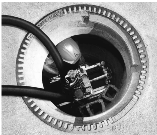
Rys. 2.51. Mała wiertnica umieszczona w studni rewizyjnej, [73] Fig. 2.51. A small rig placed in an inspection chamber, [73]
