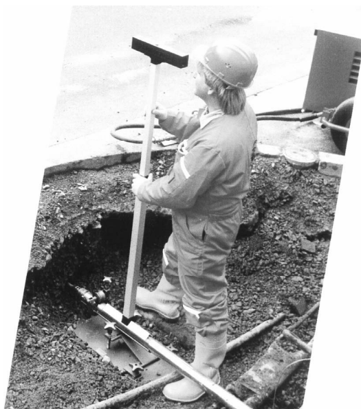
Rys. 2.5. Ustawienie przebijaka w łożu przy pomocy celownika optycznego, [73]
