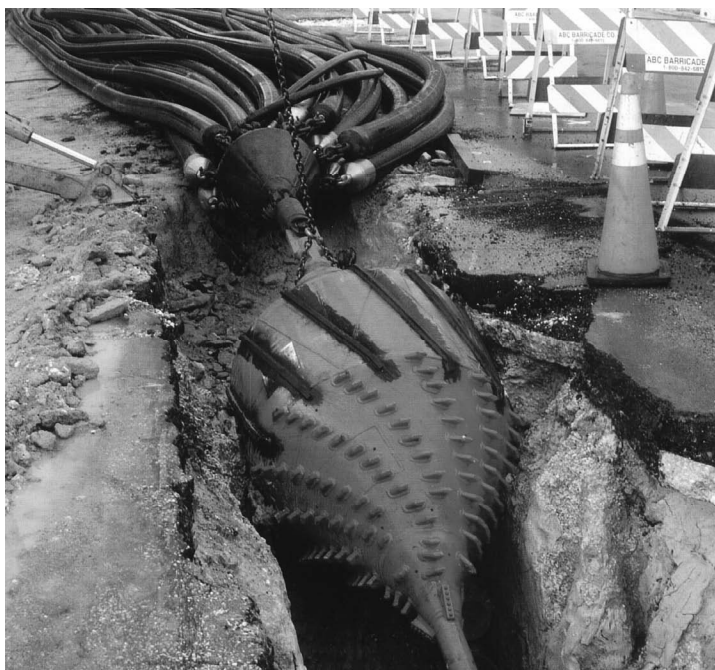
Rys. 2.40. Wciąganie kilkunastu przewodów kablowych za rozwiertakiem, [49]
