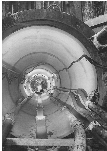
Rys. 2.83. Wnętrze wbudowywanego rurociągu, [80]
