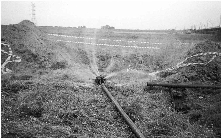
Rys. 2.41. Płuczka bentonitowa wypływająca pod ciśnieniem z dysz rozwiertaka – rozpoczęcie II etapu robót rozwiercania (zdjęcie własne dzięki uprzejmości firmy ERGOTEL)
