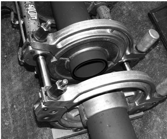
Rys. 3.8. Zgrzewanie rur polietylenowych TS, [79]
