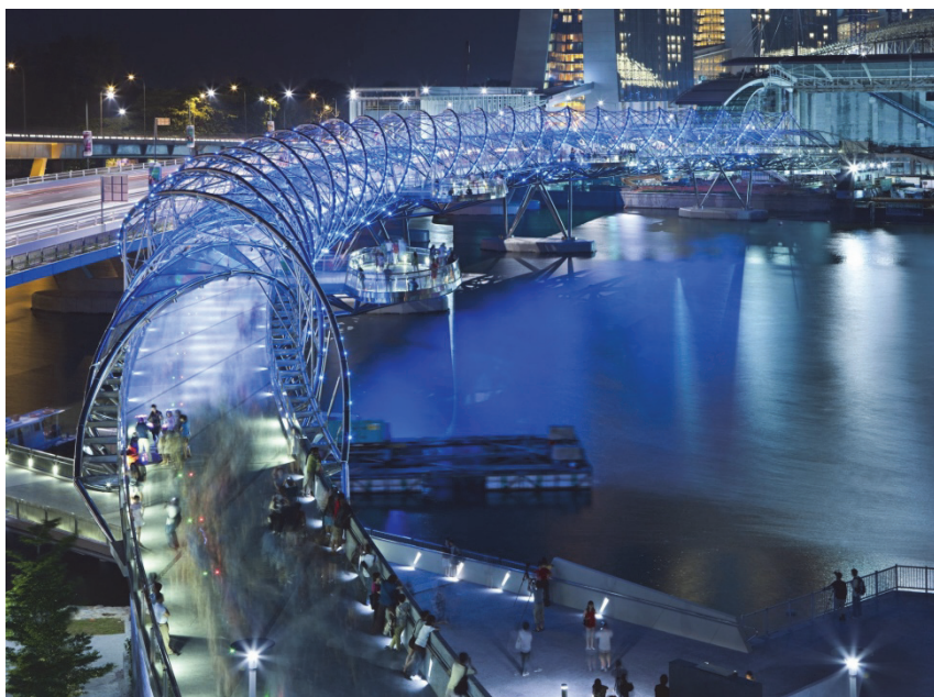
Rys. 6.1. Kładka dla pieszych Helix Bridge w Singapurze [98]
