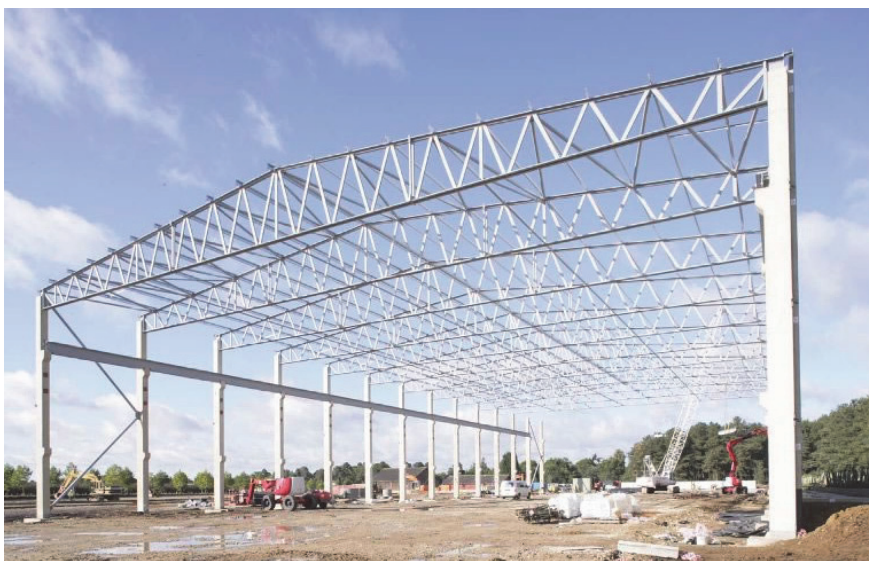
Rys. 5.5. Konstrukcja hali o układzie kratownicowym [91]
