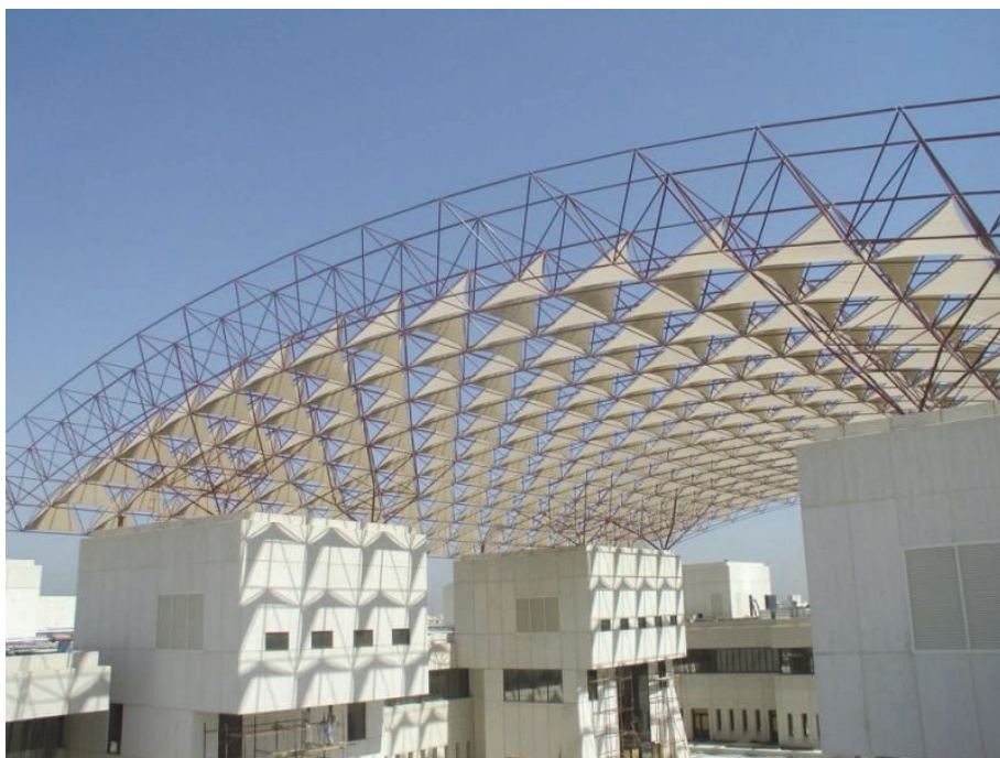
Rys. 5.16. Przekrycie strukturalne [93]
