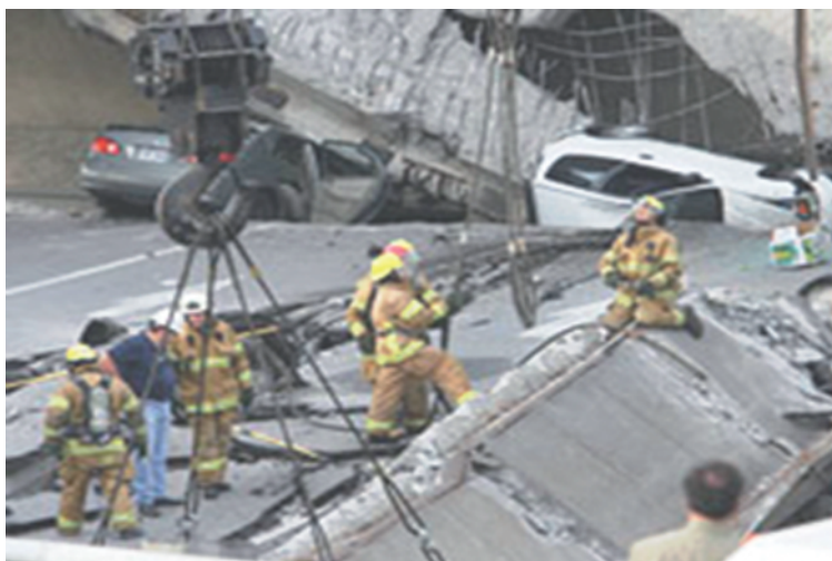
Fot. 1. Skutki zawalenia się przęsła wiaduktu w Quebecu (Kanada 2006) wywołane uszkodzeniem przyczółka (fot. Ryan Remiorz/Canadian Press- www.onet.pl ).
