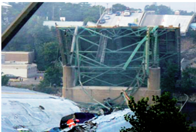
Fot. 2. Skutki zawalenia się mostu na rzece Missisipi w Minneapolis (USA 2007) wywołane uszkodzeniem elementów stalowych podtrzymujących przęsła mostu (fot. Associated Press – www.onet.pl ).
