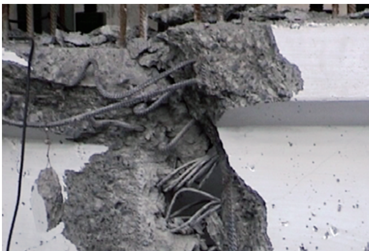
Fot. 19. Szczegół zniszczenia zbrojenia konstrukcyjnego oraz lin.
