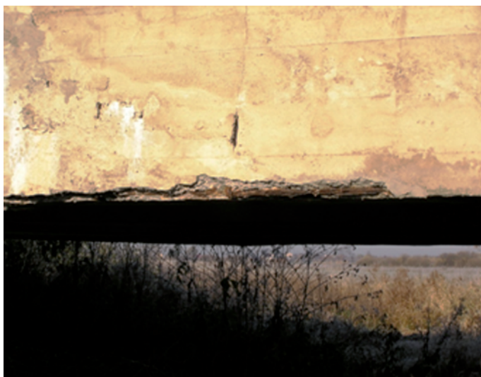
Fot. 7. Ubytki betonu, widoczne zbrojenie, osady i nacieki wapnia – obiekt mostowy o konstrukcji monolitycznej z betonu zbrojonego
