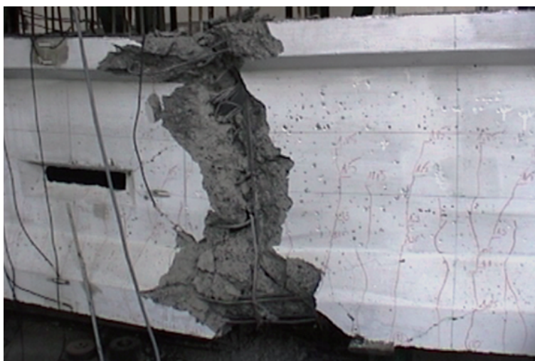
Fot. 18. Widok pęknięcia niszczonego belkę WBS.
