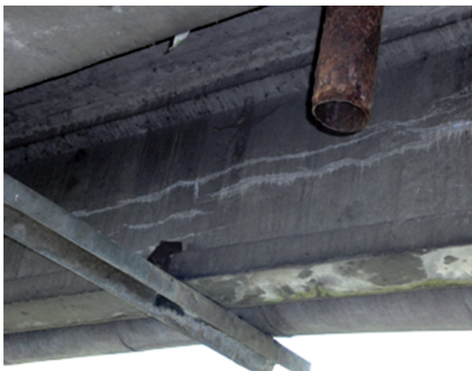
Fot. 8. Nacieki na trasie przebiegu kabla świadczące o migracji wody wzdłuż kanału – most z belek kablobetonowych.
