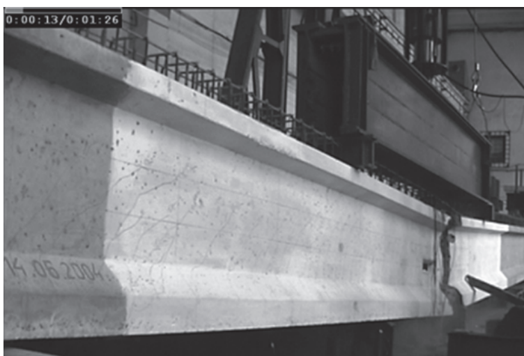
Fot. 17. Widok rys oraz pęknięcia niszczonego belkę WBS.
