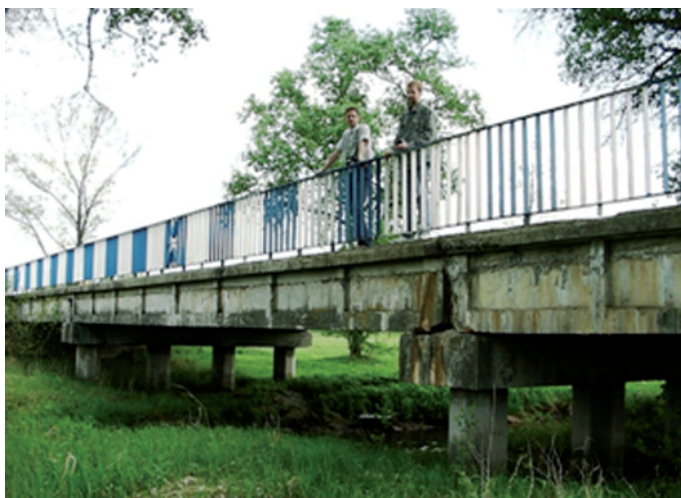
Fot. 5. Widok uszkodzeń obiektu kablobetonowego.
