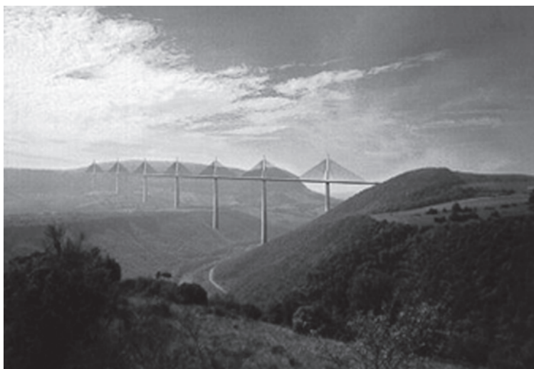
Fot. 3. Widok mostu podwieszanego Millau Viaduct– najwyższy most na świecie – na autostradzie łączącej Paryż z Barceloną ( www.onet.pl ).
