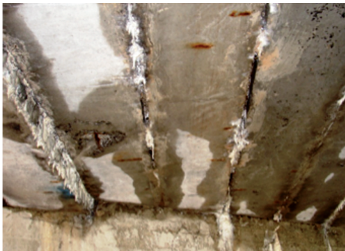
Fot. 6. Most z belek typu Kujan ze śladami przecieków i nacieków, wpływającymi na jakość i wytrzymałość belek strunobetonowych.
