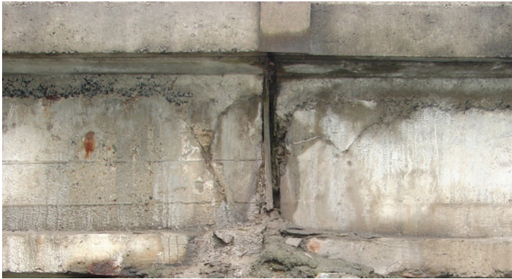
Rys. 6.9. Widoczne uszkodzenia belek na styku przy oparciu na filarze
