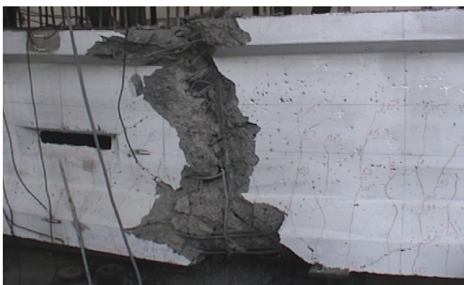
Rys. 5.23. Widok pęknięcia niszczonej belki WBS
