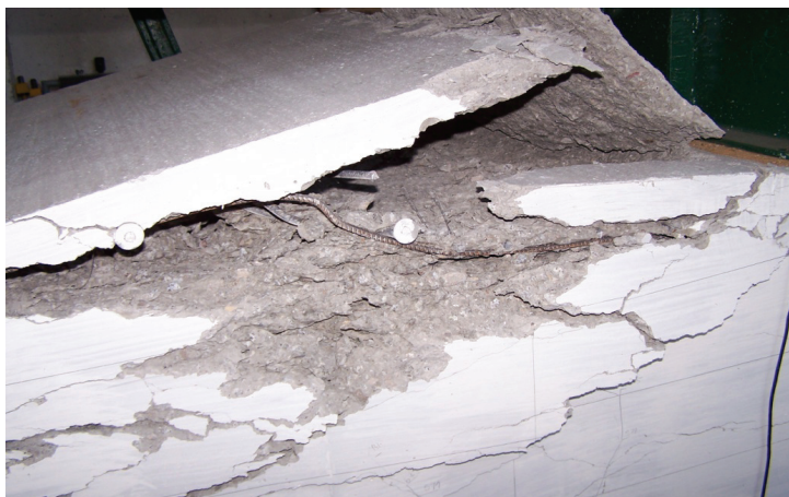
Rys. 5.40. Szczegół zmiążdżenia betonu w strefie ściskanej belki wraz z utratą sprężystości stali zbrojącej
