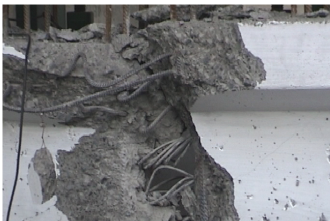
Rys. 5.24. Widok szczegółu pokazującego zniszczenie zbrojenia pasywnego oraz lin
