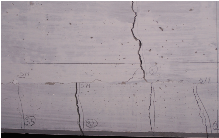
Rys. 5.38. Rozwarcie rys w chwili zniszczenia na półce belki i nadbetonie
