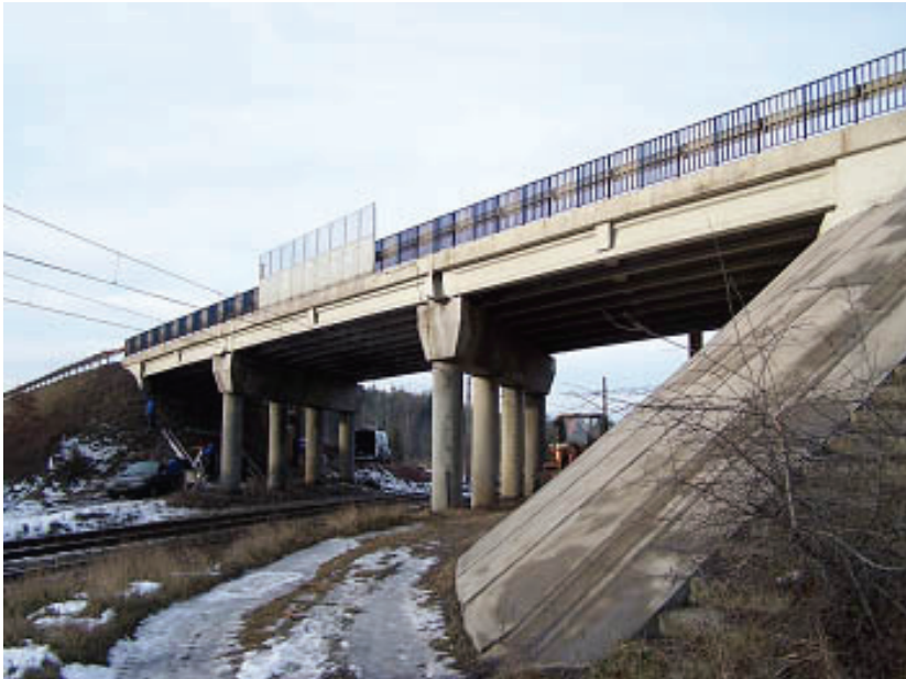
Rys. 6.21. Widok badanego wiaduku w Barczy na drodze S-7
