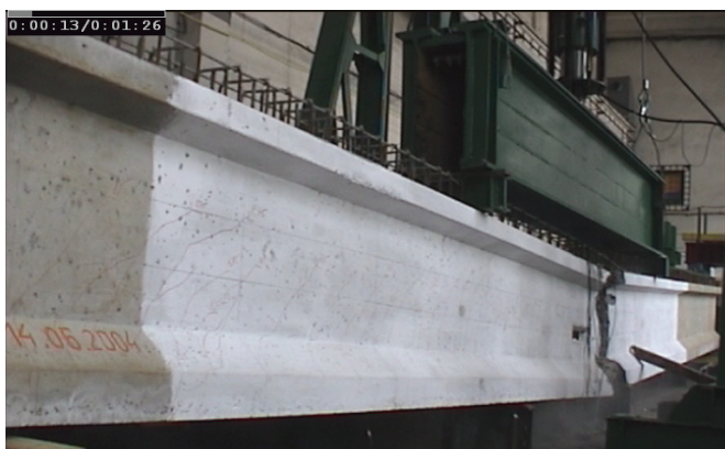
Rys. 5.22. Widok rys oraz pęknięcia niszczonej belki WBS
