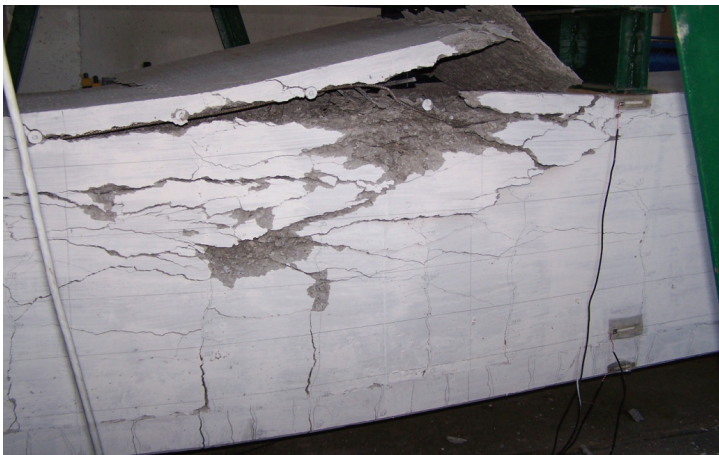
Rys. 5.39. Zmiażdżenie betonu w strefie ściskanej belki
